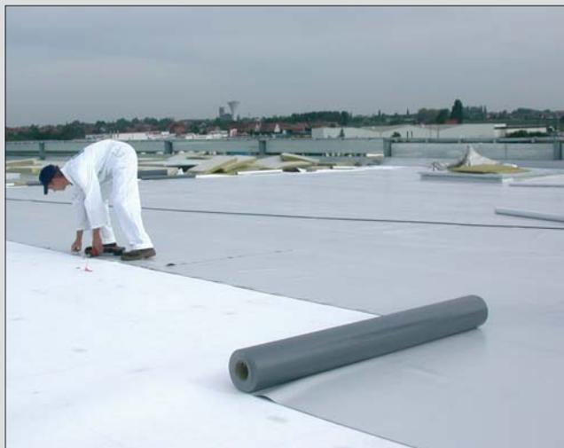
L'association réussie des panneaux Knauf Therm TTI Th 36 SE BA et du revêtement d'étanchéité SIKAPLAN 12 VG garantit un comportement au feu optimum (classement T 30/1).
