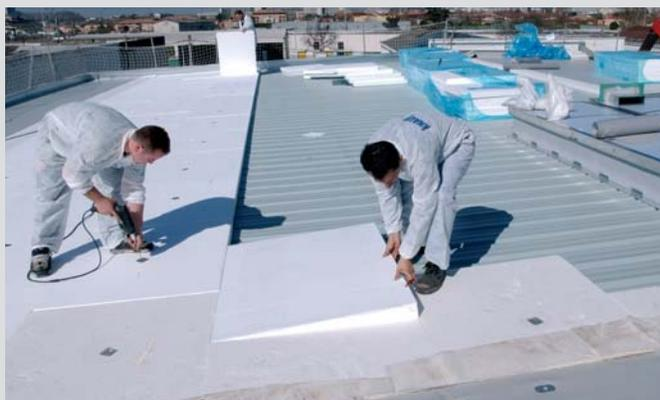
Simple, rapide et compétitive, la mise en œuvre des panneaux Knauf Therm TTI Th36 SE BA s'effectue par fixation sur le support en bac acier.
