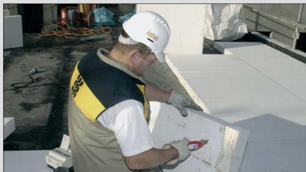
Découpe sans poussières des panneaux Knauf Therm TTI au thermocutter.
