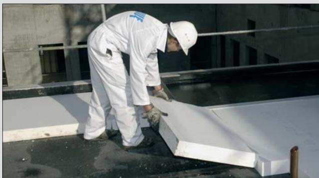
Pose libre des panneaux Knauf Therm TTI sur le pare-vapeur.
