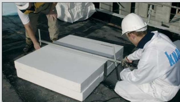
Découpe sans poussières des panneaux Knauf Therm TTI par découpeur au fil chaud.
