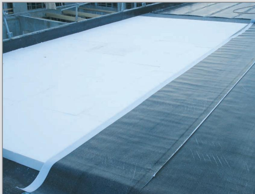
Exemple de pose directe sur le Knauf Therm TTI Th36 SE de la 1<sup>ère</sup> couche d'étanchéité à joints adhésifs.
