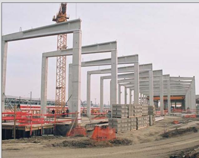
La légèreté du concept toiture intégrant 70 mm de Knauf Therm TTI Th36 SE BA a induit une réduction de charge de 285 tonnes permettant d'alléger la structure béton du bâtiment.
