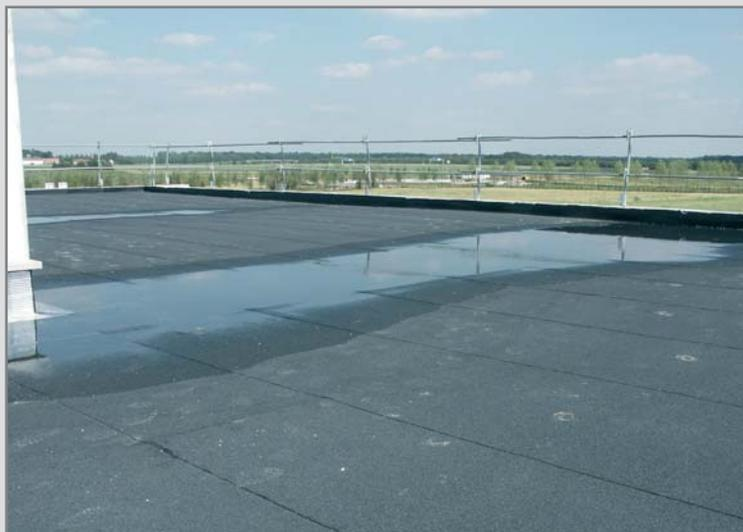
Revêtement autoprotégé semi-adhésif sur panneaux Knauf Therm Penté Th36 SE.
