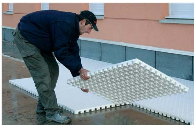
Pose des plaques Knauf Isoldrain sur le revêtement d'étanchéité.
