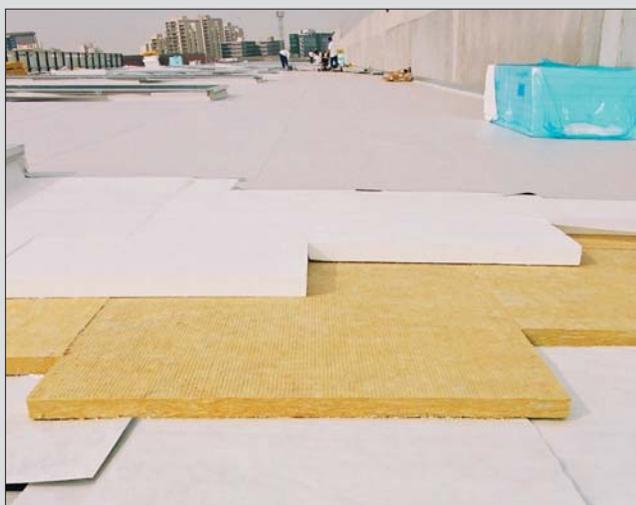
Pour répondre aux contraintes techniques de l'atelier de maintenance du TGV Est Européen, notamment en termes de correction acoustique, les 25 000 m<sup>2</sup> de toiture associent différents matériaux, dont 70 mm de Knauf Therm TTI Th36 SE BA .
