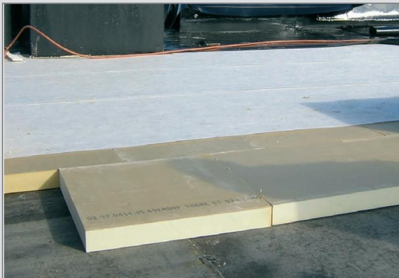
Pose libre des panneaux Knauf Thane ET sur le pare-vapeur.
