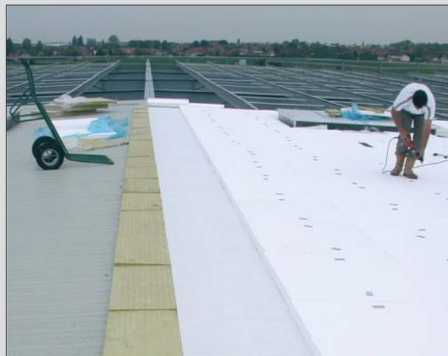
L'interposition d'un pare-vapeur entre la laine de roche et le Knauf Therm TTI Th 36 SE BA assure une absence de condensation du complexe isolant dans les conditions d'utilisation du bâtiment.
