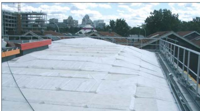
Toitures-terrasses béton avec isolation Knauf Therm Penté Th36 SE sous végétalisation.
