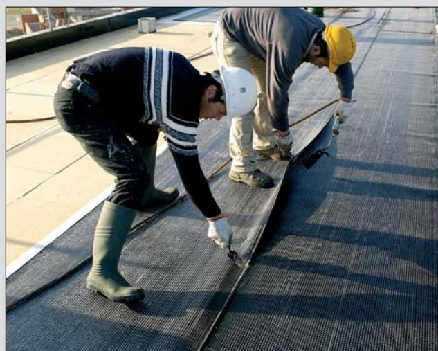
Soudure à la flamme des joints de la 1<sup>ère</sup> couche du revêtement d'étanchéité.
