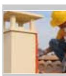
**3** La sortie de toit est simplement emboîtée sur l'embase, sa verticalité doit être vérifiée et réglée si nécessaire.
