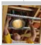
**5** Le conduit de cheminée est mis en œuvre sans renfort de charpente, sans travail de gros œuvre. Chaque raccord est sécurisé par un jonc d'assemblage avec goupille de sécurité. En final, le conduit est fixé aux entrants par un collier de soutien
