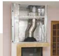
Les conduits simple paroi KITINOX sont conçus pour assurer le raccordement des conduits de cheminées métalliques ou maçonnées avec les appareils de chauffage en maisons individuelles (neuf ou rénovation).
