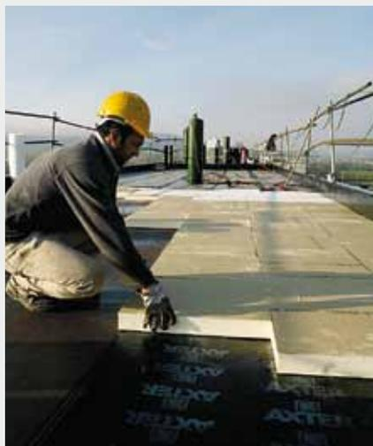
Pose libre des panneaux Knauf Thane ET sur le pare-vapeur.
